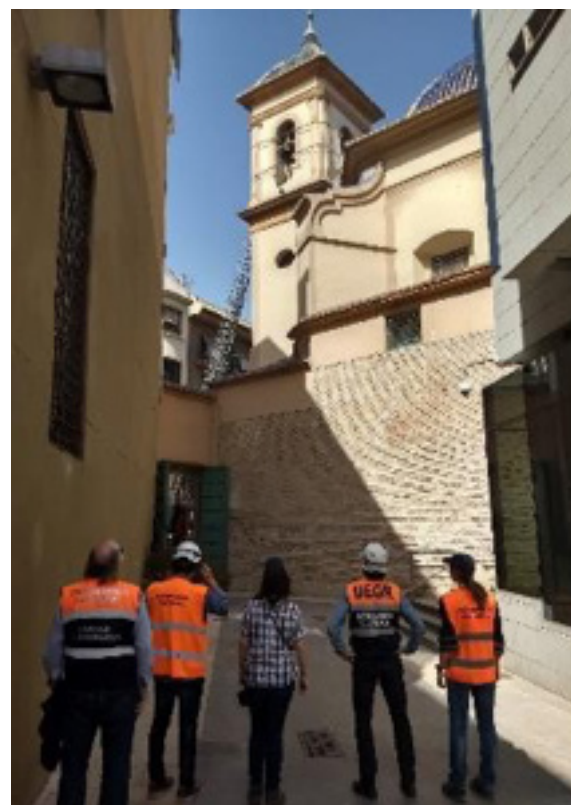
Simulacro UME 2018 en Murcia. Trabajos de estabilización de una torre dirigidos por técnicos de las Unidades de Emergencia de UEGR y Murcia. Foto J.C.
