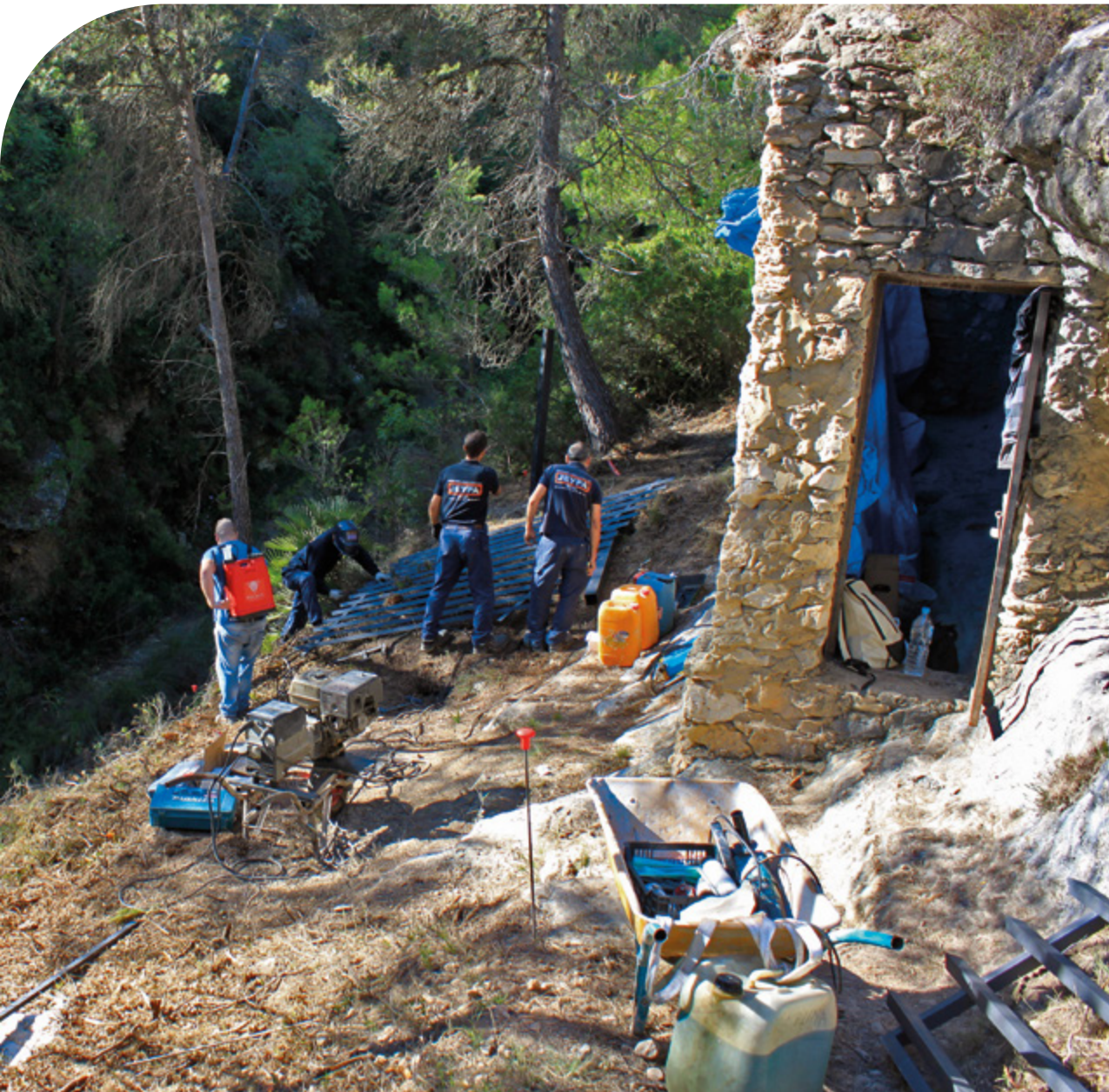
Trabajos de cambio de cierre en el Abrigo de los Gineses (Bicorp, Valencia) con operario destinado a la humectación continua de las zonas de trabajos de soldadura necesarios en el montaje del nuevo vallado, conforme a lo establecido en el Decreto 7/2004, de 23 de enero, del Consell de la Generalitat por el que se aprueba el pliego general de normas de seguridad en prevención de incendios forestales a observar en la ejecución de obras y trabajos que se realicen en terreno forestal o en sus inmediaciones. Foto TMR.
