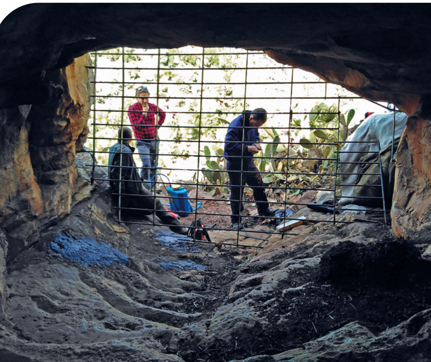
Trabajos de reparación del cierre protector en el Abric de l'Aigua Amarga (Albalat dels Tarongers, Valencia), dentro del Parque Natural de la Serra Calderona, con las oportunas medidas de seguridad: mantas humedecidas cubriendo la vegetación más próxima, mochila extintora, extintores y vigilancia. Foto TMR.
